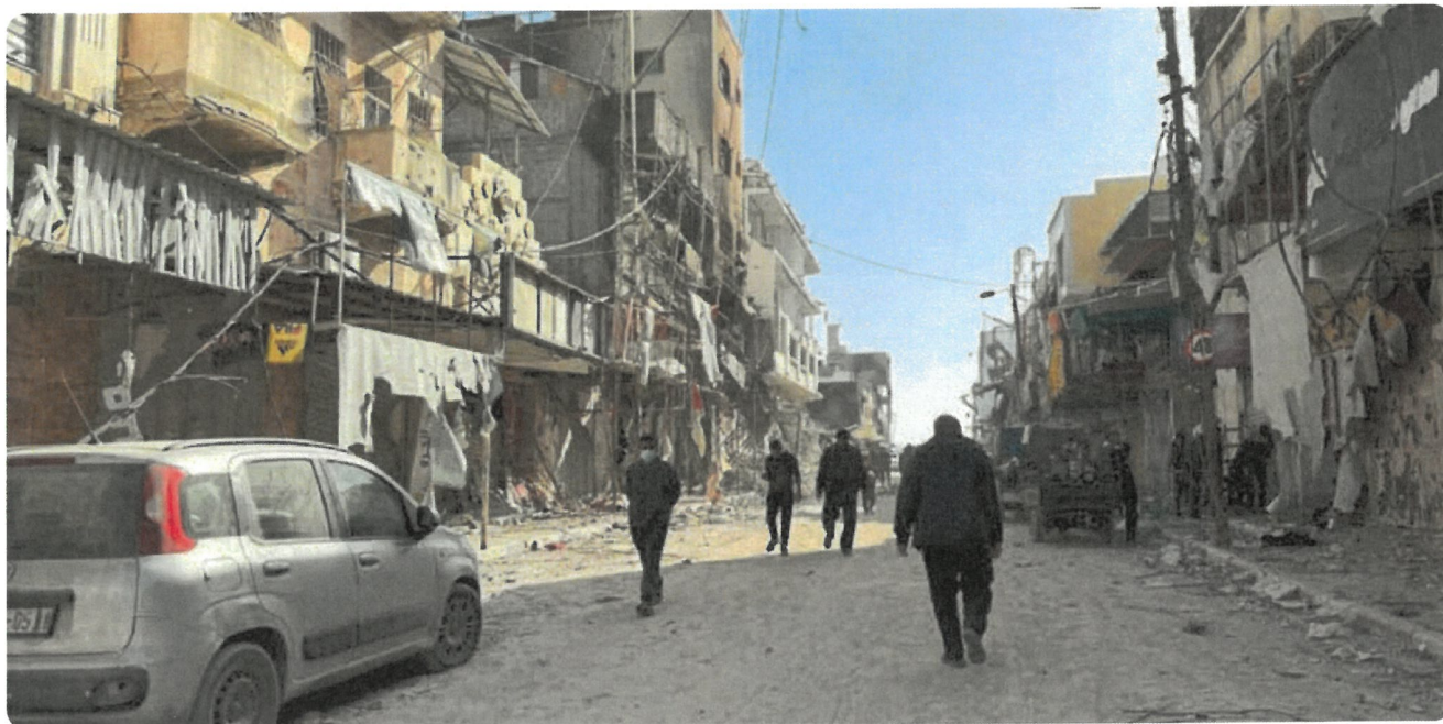
Ein zerstörter Strassenzug in Gaza
